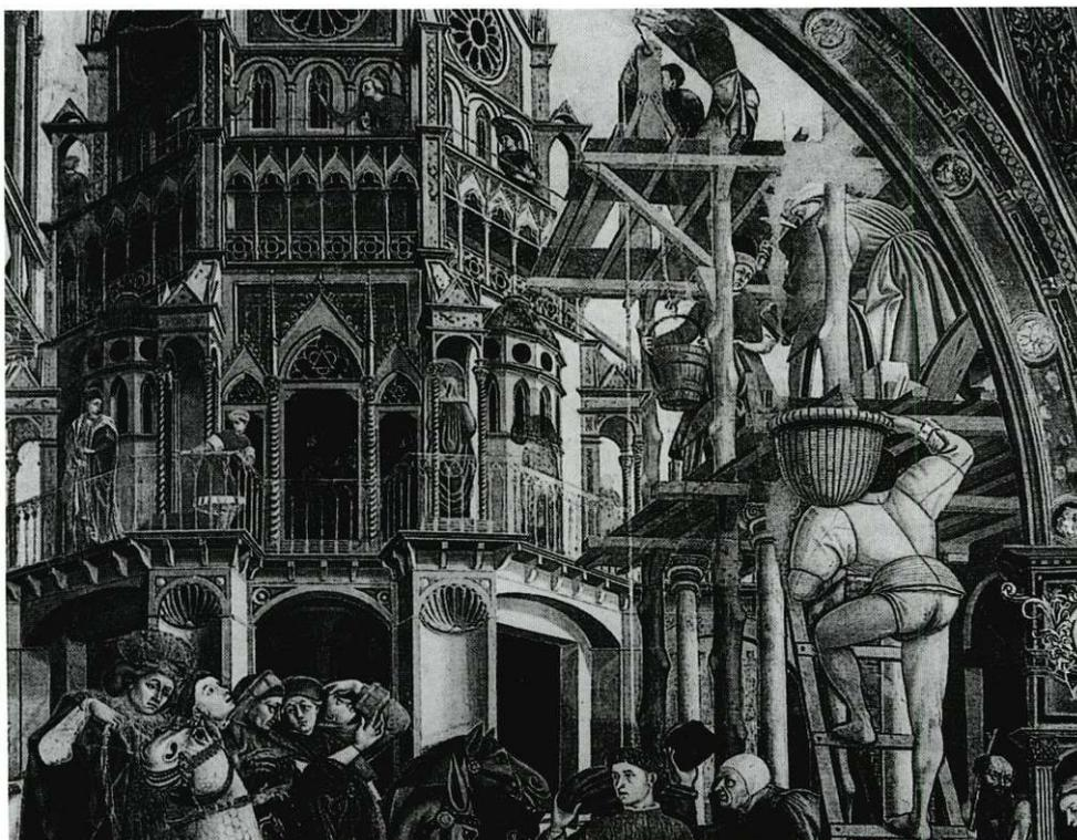
Rare exemple de chantier urbain, avec, à droite, des manoeuvres qui montent les matériaux sur un échafaudage très élaboré : il est de type encastré, à un rang de perches. Celles-ci sont ici des troncs d'arbres à peine équarris, sur lesquels les départs des branches sont toujours visibles. Les plateaux sont constitués de planches juxtaposées qui reposent sur les boulins. Des cintres en charpente sont posés dessus en attente.
